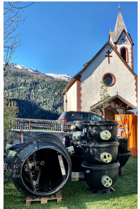
Lagerplatz Pumpenschacht / PE-Kanalschächte
