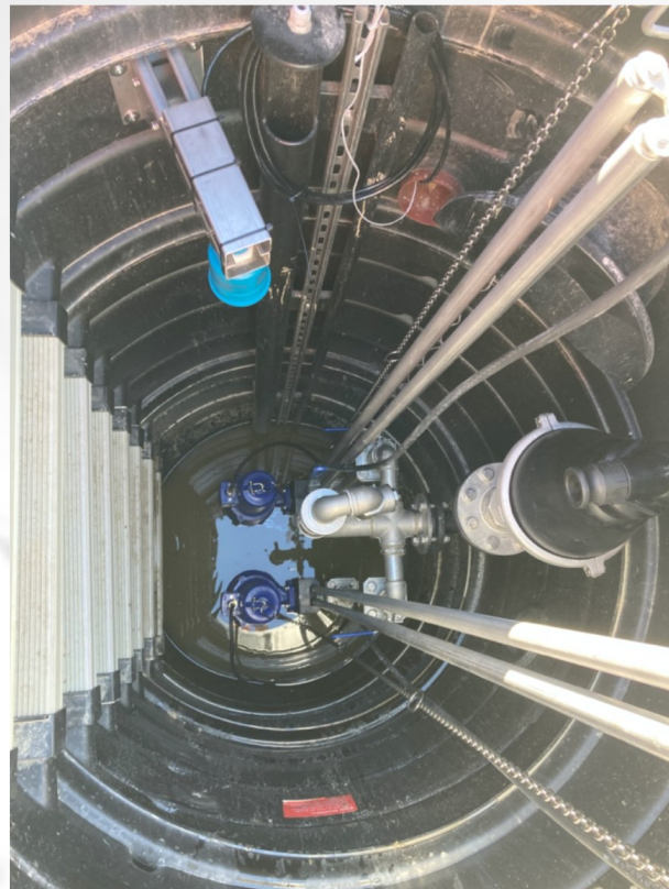
ROMOLD Pumpenschacht mit AIRVALVE Abwasserventil
